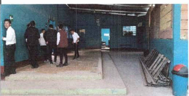
Foto 5: REPARACION DE PLANCA DE CONCRETO DE PATIO
