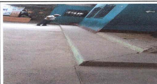
Foto 6: SUSTITUCION DE PISO
