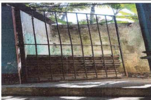
Foto 5: PORTON EN MAL ESTADO YA SE LE CAYO UN AGARRADOR QUE LO SOSTIENE EN LA PARED.
